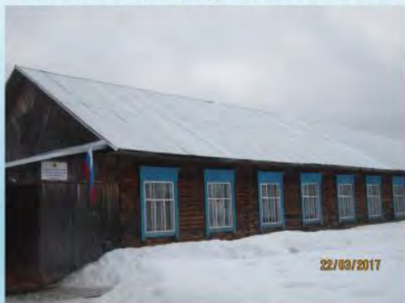
Капитальный ремонт кровли здания Ужугской основной общеобразовательной школы
